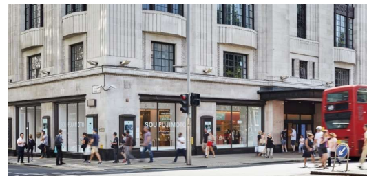
ジャパン・ハウス ロンドン外観
