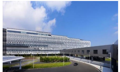
羽田エアポートガーデン 施設外観(空港側より撮影)
