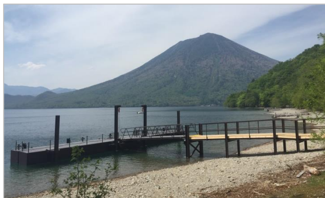
△新棧橋「大使館別荘記念公園」全景（工事施工中）
